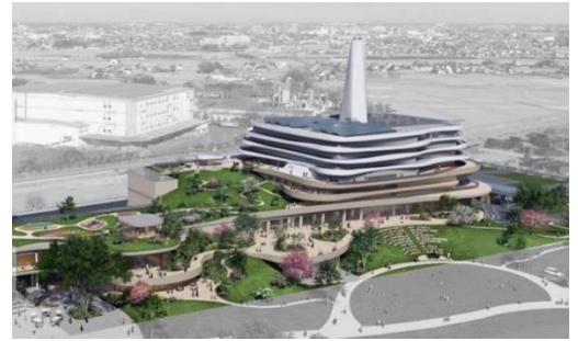
建設中の新たなごみ処理施設
